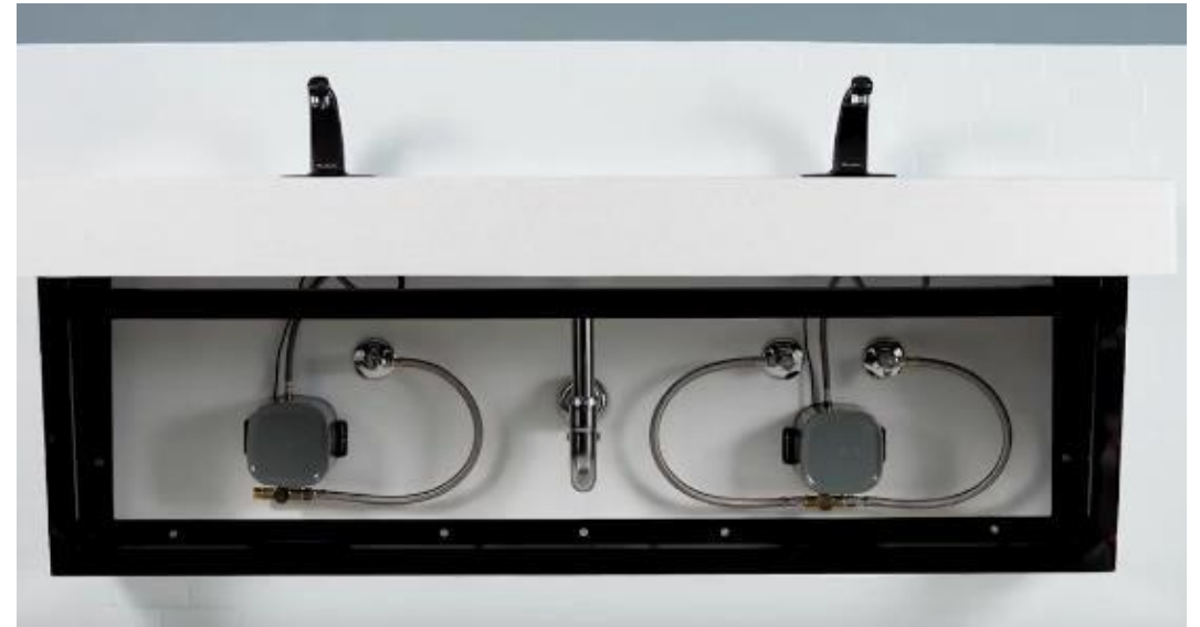
Acceso Debajo de la Cubierta
